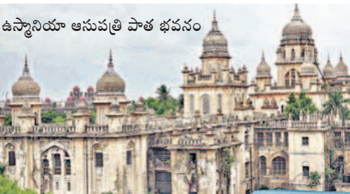
ఉస్మానియా ఆసుపత్రి పాత భవనం కార్యదర్శి శాంతికుమారి,ఇతర అధికారులు ఈ సమావేశంలో పాల్గొన్నారు. స్పీడ్ జాబితాలో ఉన్న 19 పనుల్లో ఉస్మానియా ఆసుపత్రి కోత్త భవన నిర్మాణం,15 కోత్త నర్సింగ్ కాలేజీలు,28 కోత్త పారామెడికల్ కాలేజీలు,జిల్లాల్లో సమాఖ్య భవనాల నిర్మాణాలకు సంబంధించిన ప్రణాళికలను ముఖ్యమంత్రి చర్చించారు.
